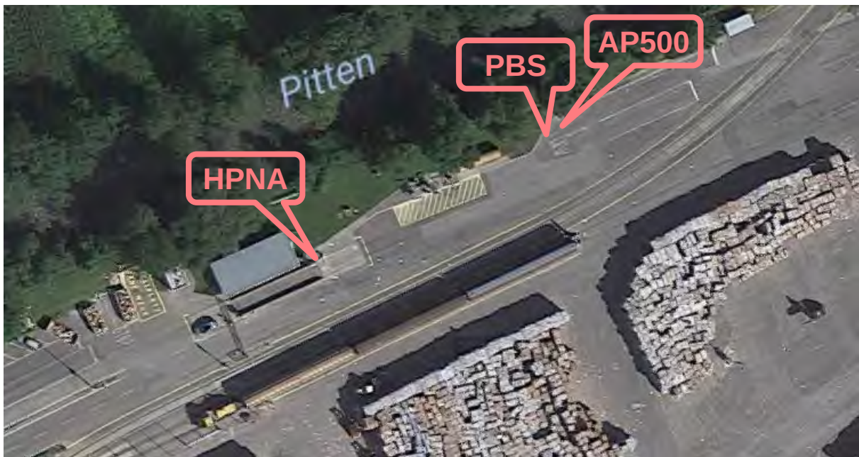
Abbildung 3: Luftaufnahme des Wareneingangs in Pitten mit Positionen der einzelnen Messtechniken
